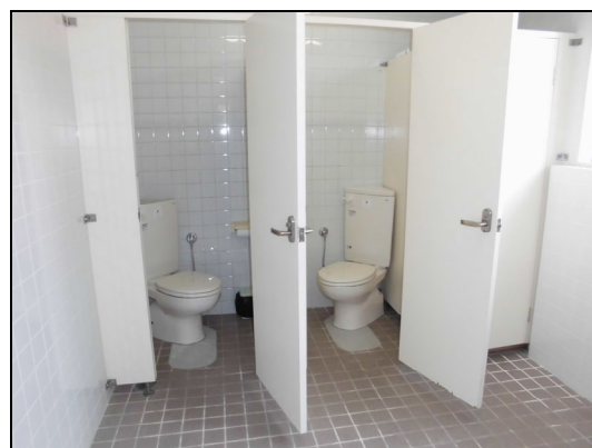
○トイレの改修
